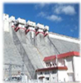
秋田県営水力発電所
